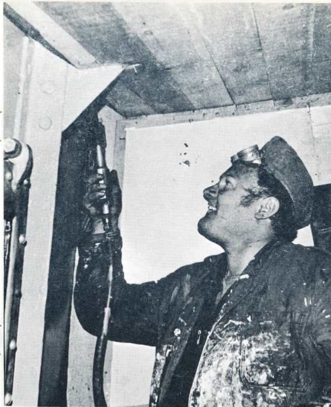
Arbetet ombord fortgår ständigt. Stundtals är det både hårt, kallt och smutsigt. Här pågår rosthackning i ett skrymsle. Verktöget är tryckluftsdrevet.
